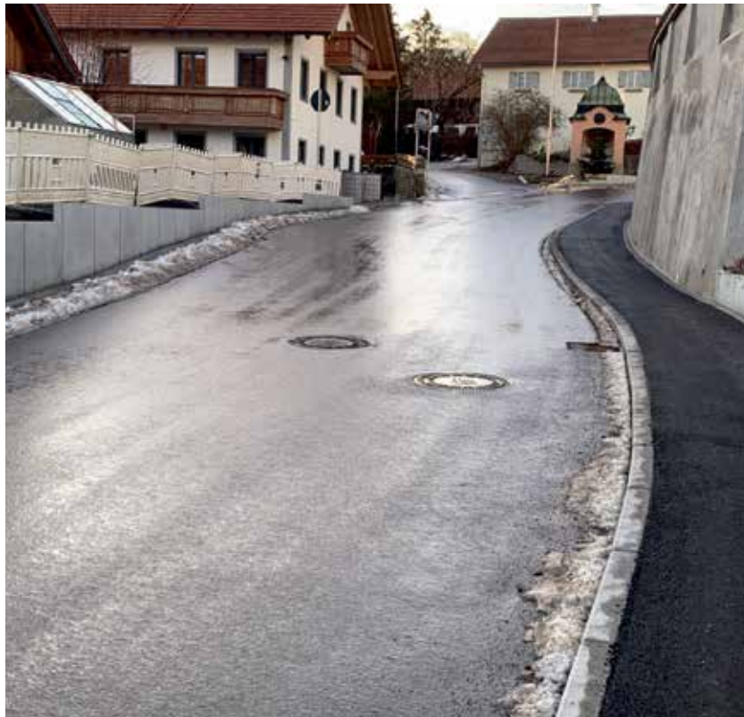
Jetzt gibt es in Dröbbling endlich einen Gehsteig, leider aber auch viel neuen Beton, der durch Farbe und Bepflanzung aufgewertet werden sollte.
